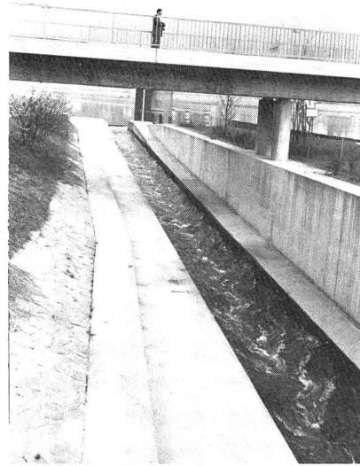
Bild 14, links. Schleuse Leerstetten in Richtung Oberhaupt. Im Hintergrund das bereits eingebaute Hubsenktor. Mit dieser Schleuse wird eine Höhendifferenz von 24,7 m bewältigt.
