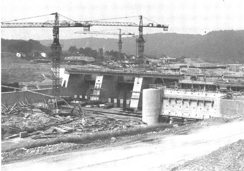
Bild 8, links. Schleusenanlage Riedenburg, Blick vom künftigen Unterwasser stromaufwärts. Rechts Einlauf zum Pumpen-/Turbinenhaus, in der Mitte die drei Wehrröhrungen mit Energieumwandlern, links schliesst die untere Vorhafenmauer an.
