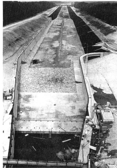
Bild 3, links. Schleuse Leerstetten, Oberhaupt, Blick Richtung Oberwasser. Im Vordergrund der Einlauf zu den Sparbecken einerseits und zur Füllung der Schleuse andererseits. Die auf Betonpfeilern durchgezogene Schürze dient den einfahrenden Schiffen als Leitwerk und hält sie vom Einlauf fern.
