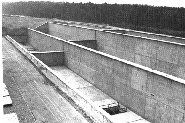
Bild 10. Die drei Sparbecken der Schleuse Leerstetten.
