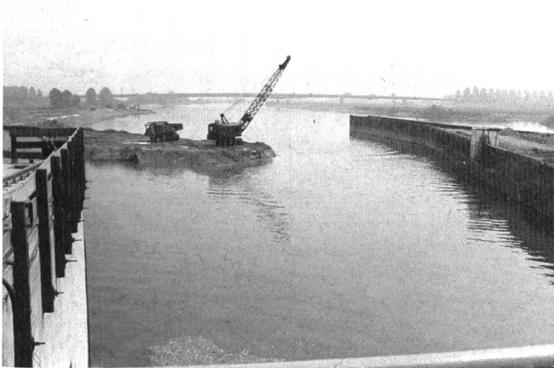
Bild 17. Entfernen eines Abschlussdammes bei der Schleuse Straubing.
