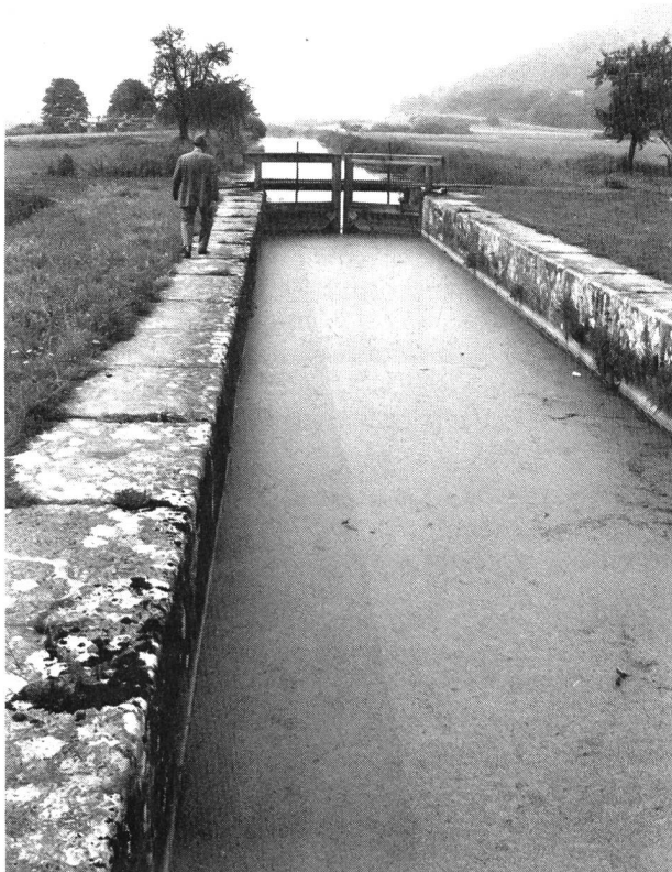
Bild 2. Eine der 100 Schleusen des in den Jahren 1836 bis 1845 erstellten Ludwigkanals. Die Schleusen waren 80 bis 84 Fuss (23,36 bis 24,25 m) lang, und 14½ Fuss (4,32 m) breit. Der Tiefgang betrug 1,17 m.
