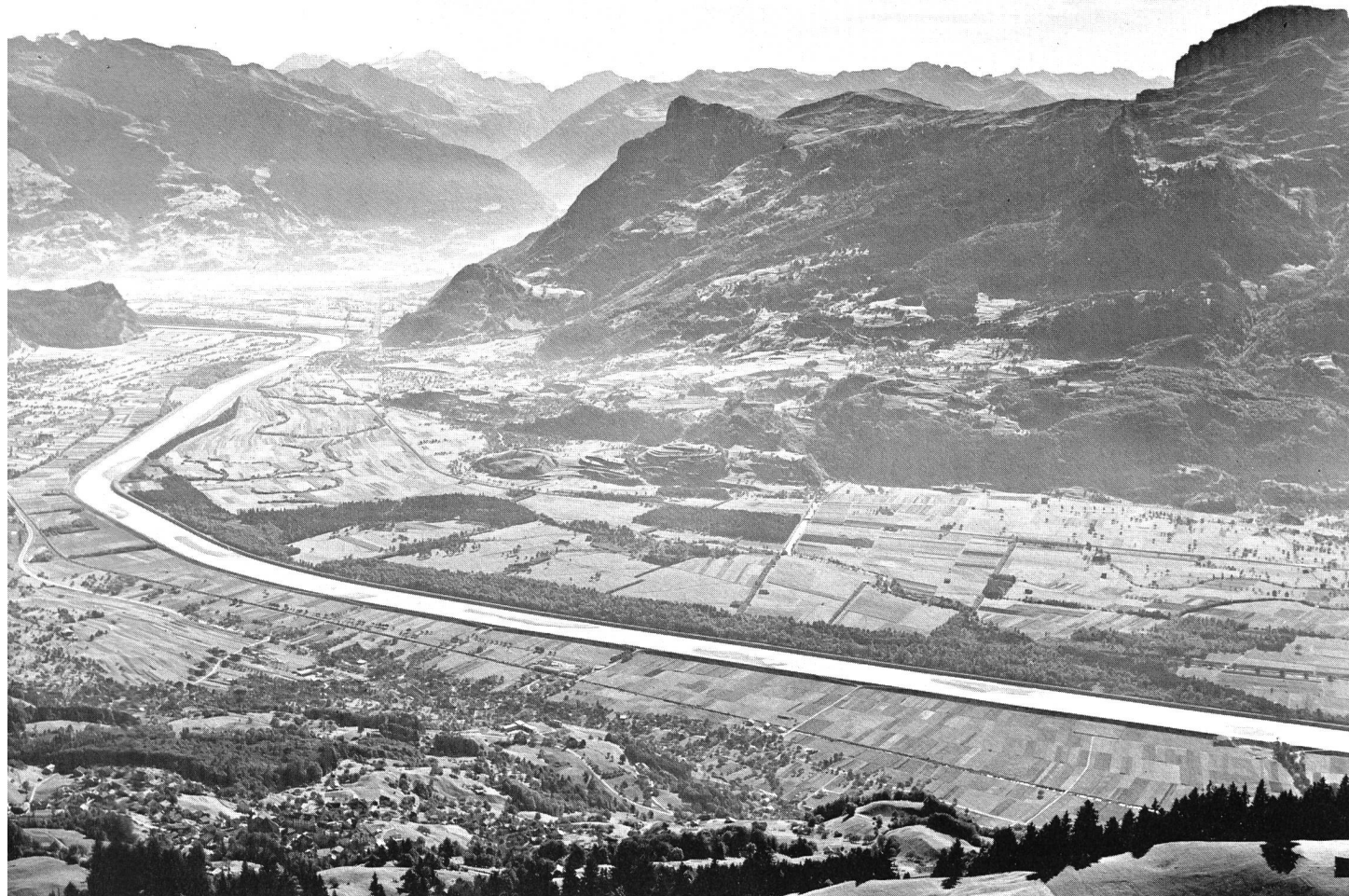
Bild 8. Rhein bei Sargans. Alternierende Bänke in einem korrigierten Fluss, «Läufe» («Riffles») zwischen, «Hinterwasser» («Pools») neben den Bänken. (Foto: W. Wachter, Schaan, FL)
