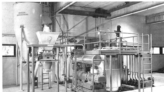
Bild 1. Die Bühler-Schlamm-trocknungsanlage ZTD-2/6, wie sie in der Abwasserreinigungsanlage Altenrhein installiert ist.
