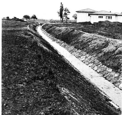
Bild 9. Der neuerstellte Saschielgraben, mit naturverbundenem Ausbau. Der alte Baumbestand blieb erhalten.
