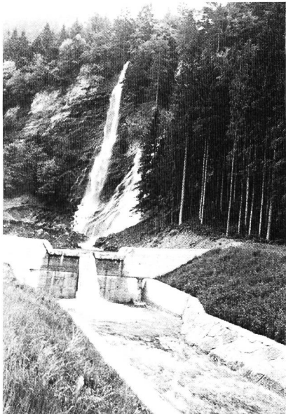
Bild 4. Rechts der Saarfall, links der Wasserfall der Kleinen Saar, während deren Umleitung für den Bau des Verbindungsgrabens in den Kiesfang des Saarkanals. So existierten hier während der Bauzeit vorübergehend zwei imposante Wasserfälle. Absperrmauer des Kiesfanges, Tosbecken und oberster Teil des neuen Saarkanals.
