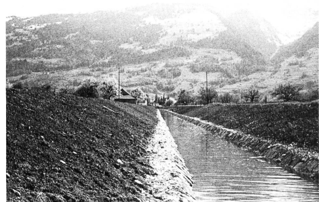
Bild 3. Der vertiefte und verbreiterte Vilterser—Wangser-Kanal östlich von Sargans.
