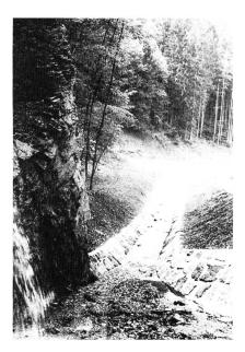
Bild 6. Links ist noch ein Teil des Wasserfalles der Kleinen Saar zu sehen. Die neue, gepflästerte Abflussrinne führt das Wasser in den Kiesfang des Saarfalles. Damit konnte der alte Lauf der Kleinen Saar aufgehoben und in geringer Länge abgeleitet werden.
