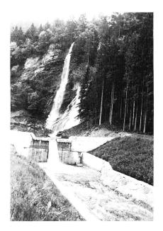
Bild 4. Rechts der Saarfall, links der Wasserfall der Kleinen Saar, während deren Umleitung für den Bau des Verbindungsgrabens in den Kiesfang des Saarkanals. So existierten hier während der Bauzeit vorübergehend zwei imposante Wasserfälle. Abspermauer des Kiesfanges, Tosbecken und oberster Teil des neuen Saarkanals.
