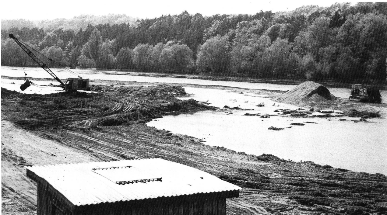
Bild 1. Baggerung im Rhein bei der Thurmündung. Der Rhein fliesst von rechts nach links. Mit einem Schürfkübel-Bagger (links) wird das von der Thur in den Rhein gebrachte Geschiebe herausgenommen. (Foto Kunz, Bülach)
