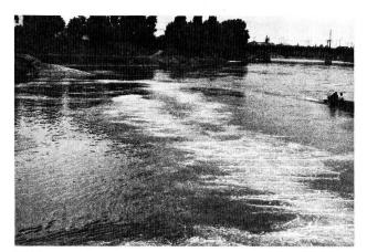
Bild 3. Ausströmende Luftblasen im unteren Vorhafen Birsfelden. Beide Schläuche des Luftschleiers sind in Betrieb; die Luftmenge beträgt 70 m³ Luft/min. Blickrichtung vom Trenndammkopf zur Buhne.
