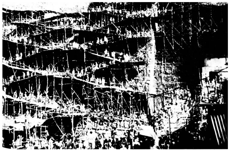
Bild 5. Altertümlich arbeitsintensive, doch beschäftigungspolitisch zweckmässige Baumethode an der 144 m hohen und 1,9 Mio m³ Mauerwerk erfordernden Gewichtsstaumauer Srisailam am Fluss Krishna. (Foto: H. Kreuzer, Kirchdorf/AG)
