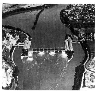
Das Doppelkraftwerk Augst-Wyhlen. Die Fotomontage zeigt den vorgesehenen Einbauort der neuen Maschinengruppe in der ersten Stauwehröffnung vom deutschen Ufer aus gesehen.
