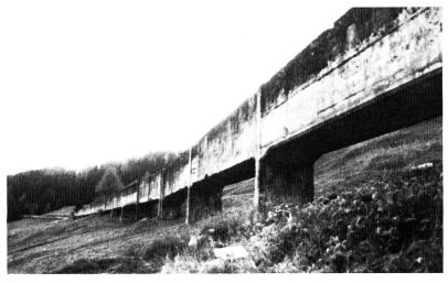
Bild 1, links. Die Triebwasserleitung Heidsee—Obervaz, die seit Januar 1977 ausser Betrieb ist, wird abgebrochen. Aufnahme vom 22. Oktober 1977 bei Koordinate 761.600/175.650. Die Aussenmasse des Kanals sind: Höhe rund 1,8 m; Breite 1,45 m. Der Stützenabstand beträgt etwa 8 m.
