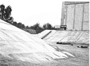
Seit es gelungen ist, PE-Bahnen rationell und sicher auf der Baustelle zu verbinden, wird PE als Deponieabdichtung bevorzugt eingeselzt.
