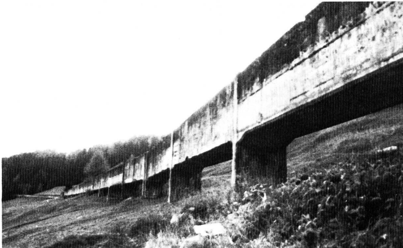
Bild 1, links. Die Triebwasserleitung Heidsee—Obervaz, die seit Januar 1977 ausser Betrieb ist, wird abgebrochen. Aufnahme vom 22. Oktober 1977 bei Koordinate 761.600/175.650. Die Aussenmasse des Kanals sind: Höhe rund 1,8 m; Breite 1,45 m. Der Stützenabstand beträgt etwa 8 m.
