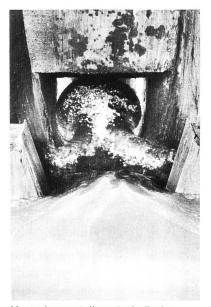
Venturimessstelle unterhalb des Drosselschiebers zur Befehlsgabe an die Regelautomatik und Schieber
