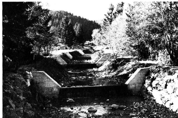
Bild 2. Die Sanierung des Nidlaubaches im Kanton Schwyz. Mittellauf: Leichte Abtreppung mit Eisenbetonschwellen, Blockwurf, Bepflanzung und beidseitigen Unterhaltswegen.
