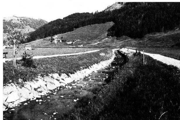
Bild 3. Die Sanierung des Nidlaubaches im Kanton Schwyz. Unterlauf: Blockwurf und Blockschwellen mit Niederwasserrinne und Vorland in landwirtschaftlich genutzter Zone.
