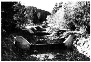
Bild 2. Die Sanierung des Nidlaubaches im Kanton Schwyz. Mittellauf: Leichte Abtreppung mit Eisenbetonschwellen, Blockwurf, Bepflanzung und beidseitigen Unterhaltswegen.
