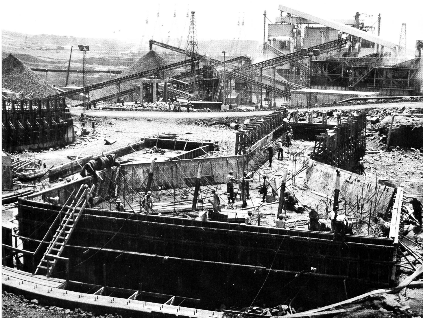
Bild 6. Betonierarbeiten an Pfeiler der rechtsufrigen Seitenmauer.
