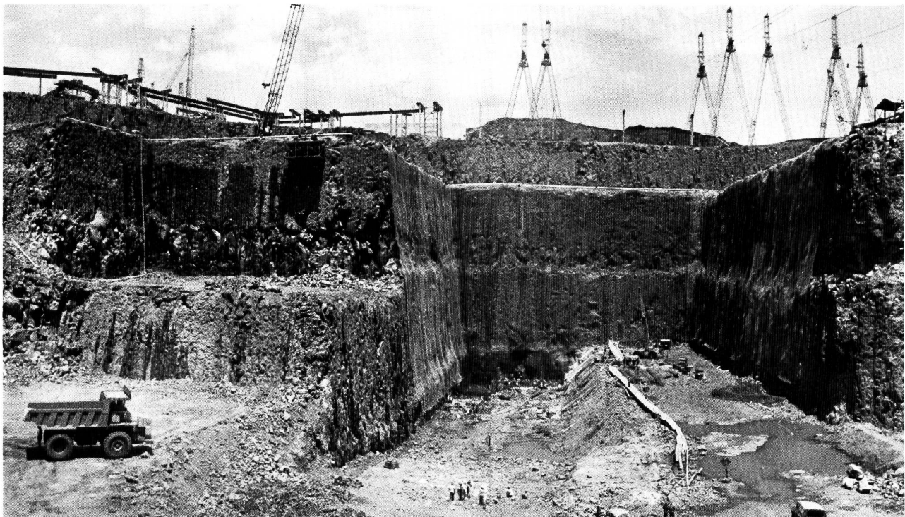
Bild 4. Aushub für rechtsufriges Ende des Maschinenhauses Itaipu; dahinter die Türme der sieben 20-t-Kabelkräne (unten vorne Menschengruppe!).
