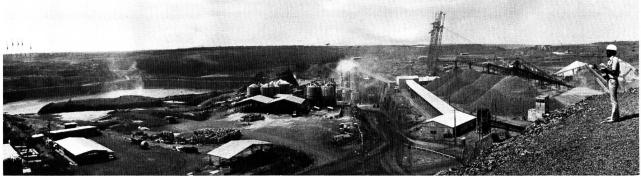
Bild 3. Panorama der Hauptsperrstelle Itaipu (v. l. n. r.): rechtsufrige Kabelkrantürme, oberwasserseitiger Fangdamm, Einlauf, Umleitkanal, Zementsilos und Betontürme, Kühlanlage, Inksufrige Kabelkrantürme, Aufbereitungsanlage.
