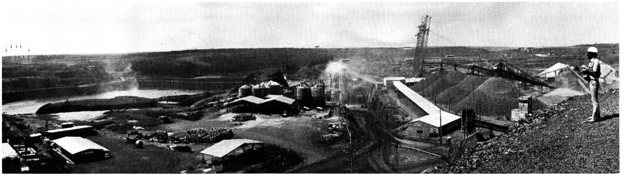
Bild 3. Panorama der Hauptsperre Itaipu (v. l. n. r.): rechtsufrige Kabelkrantürme, oberwasserseitiger Fangdamm, Einlauf, Umleitkanal, Zementsilos und Betontürme, Kühlanlage, linksufrige Kabelkrantürme, Aufbereitungsanlage.
