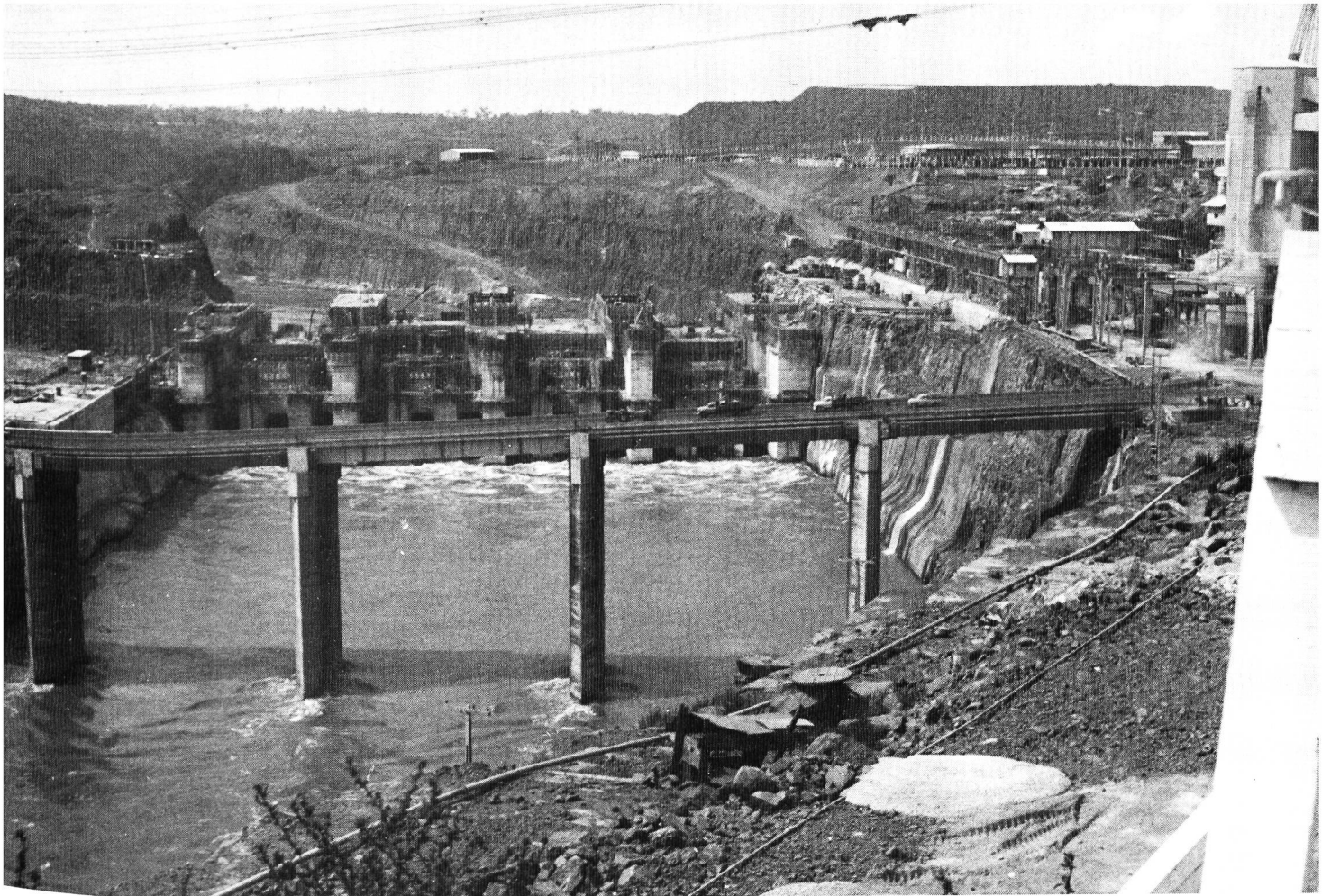
Bild 5. Umleitkanal für 30 000 m 3 /s mit Abschlussbauwerk (hinter Dienstbrücke).
