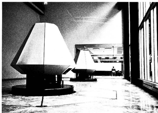
Bild 2. Der neue Maschinensaal des 1969/70 erneuerten Kraftwerks Campocologno. Die mittlere jährliche Erzeugungsmöglichkeit konnte von 112 Mio kWh auf 174 Mio kWh gesteigert werden. 1 Druckleitung, Durchmesser 1800/1700/1600 mm; 2 x 23 950-kW-Francis-turbinen; Nettofallhöhe 416 m; nach späterem Aufstau wäre eine Leistung von 2 x 24 800 kW möglich [1].
