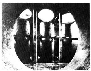
Figure 4. Vannes cylindriques en amont des conduites forcées.
