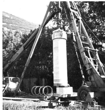
Bilder 10.7.1. und 10.7.2. Bohrarbeiten für die Grundwasserfassung Rossboden der Stadt Chur.
