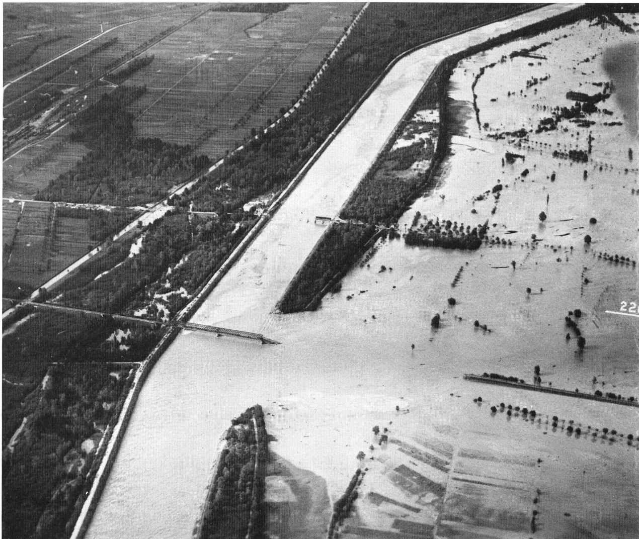
Bild 5.9. Die Dammbuchsstelle am 26. September 1927. Das Unterland des Fürstentums Liechtenstein wurde überschwemmt.
