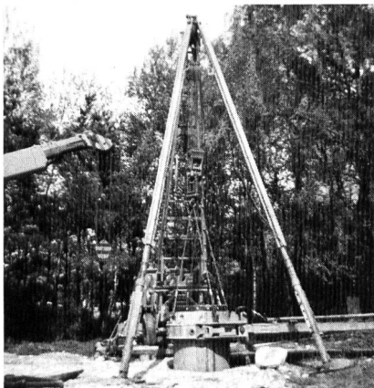
Bilder 10.7.1. und 10.7.2. Bohrarbeiten für die Grundwasserfassung Rossboden der Stadt Chur.
