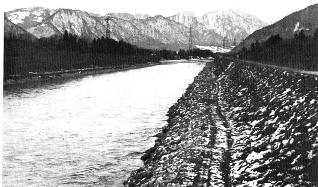
Bild 6.5.2. Der Rhein bei Intervaz-Mastrils, Blick talabwärts, Falknis. Die linke Seite ist unbewehrt. Die Blocksteinwuhre auf der rechten Seite stammt von verschiedenen Bauetappen, sie ist zum Teil sehr alt.
