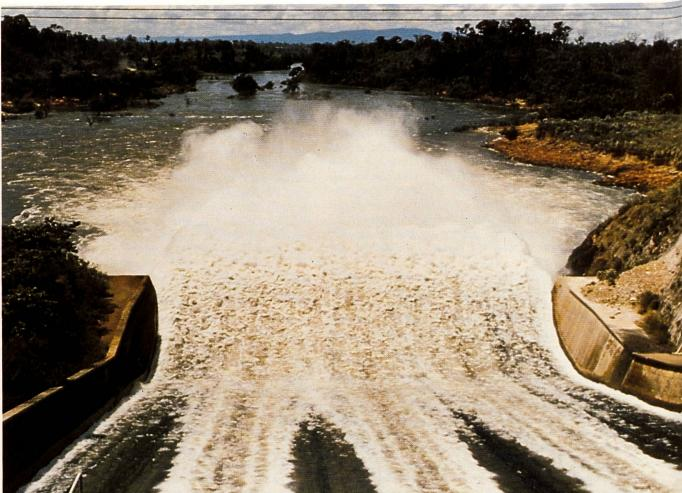
Bild 8. Die Hochwasserentlastung beim Flusskraftwerk Nam Ngum, dem einzigen grösseren Elektrizitätswerk in Laos.
