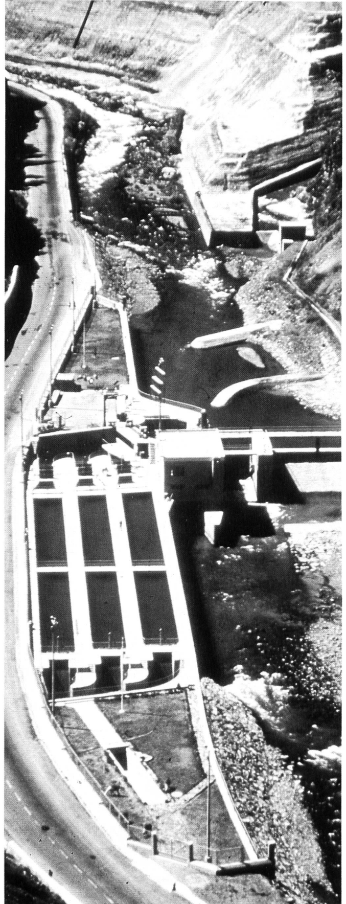
Bild 3, links oben. Wasserseitige Ansicht der 82 m hohen Pfeilerstaumauer Al Massira während des Baus.
