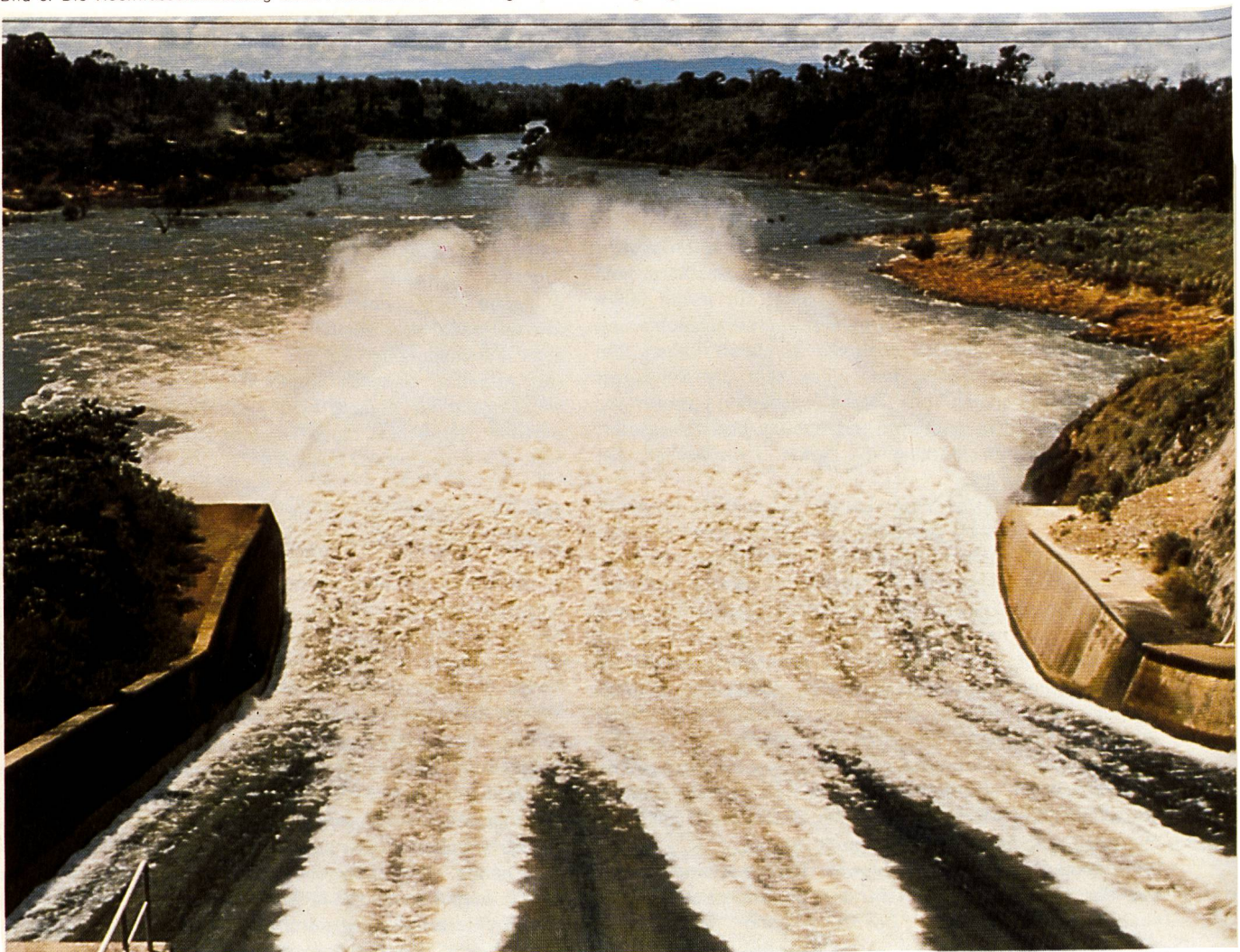
Bild 8. Die Hochwasserentlastung beim Flusskraftwerk Nam Ngum, dem einzigen grösseren Elektrizitätswerk in Laos.
