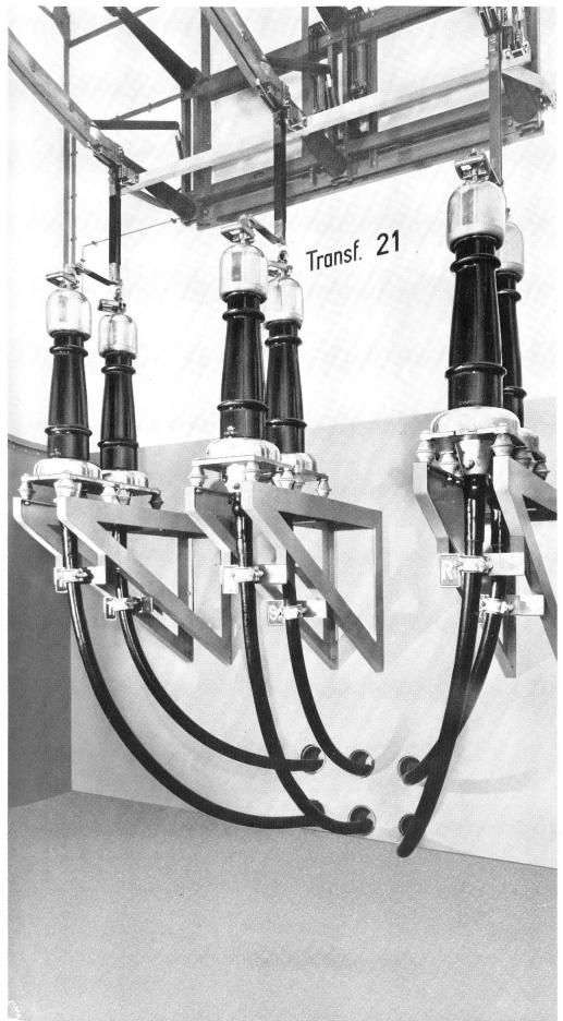
60 kV Einleiter-Oelkabel 1x800 mm² mit Innenraum-Kabelendverschlüssen als Verbindungsleitung zwischen Schaltanlage und Transformator in einem Unterwerk 220/60 kV
