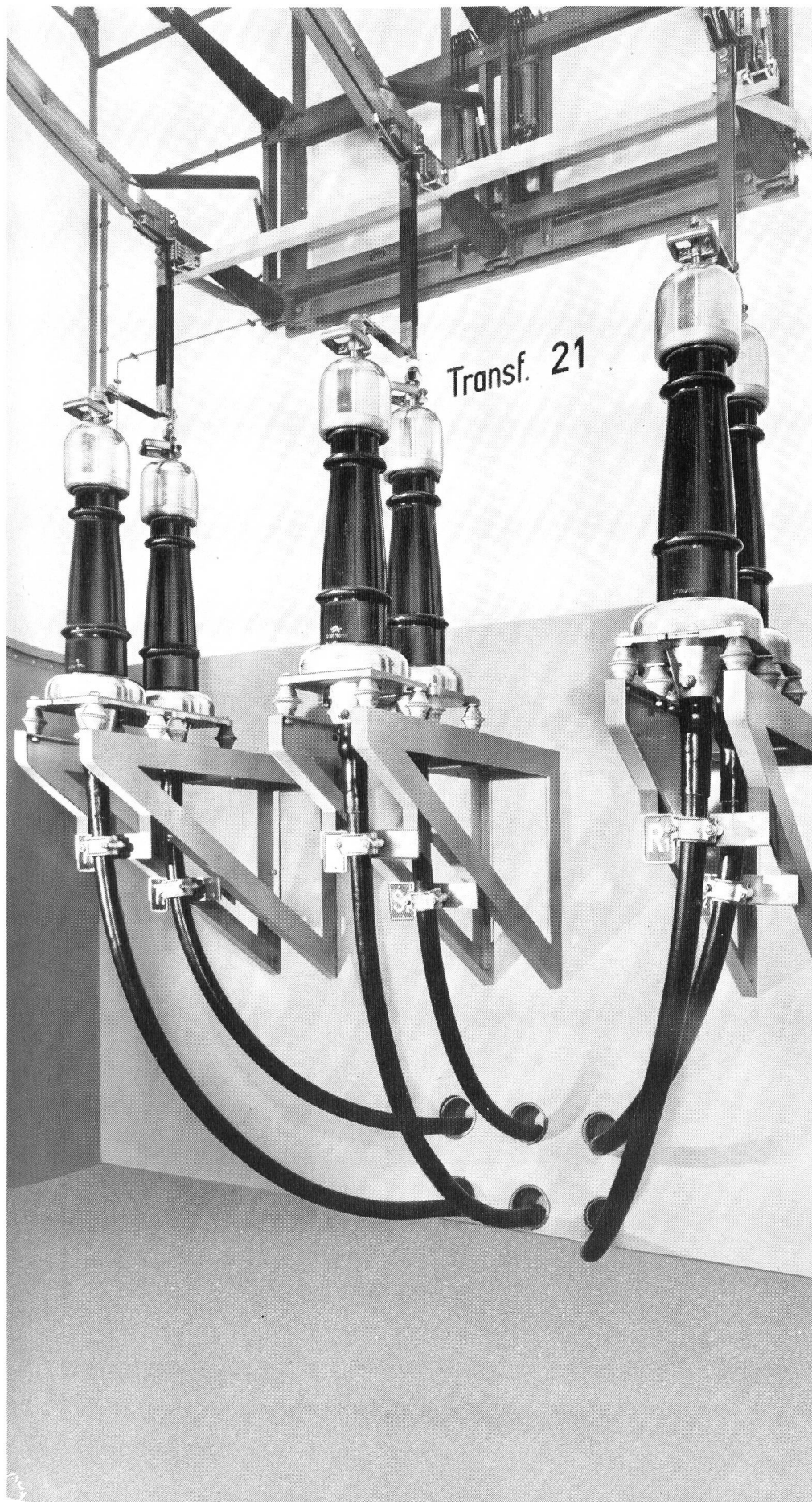
60 kV Einleiter-Öelkabel 1x800 mm 2 mit Innenraum-Kabelendverschlüssen als Verbindungsleitung zwischen Schaltanlage und Transformator in einem Unterwerk 220/60 kV
