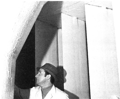
Bild 3. Leitschaukeln und Wasserführungsschild nach der Konservierung mit lösungsmittelfreier Beschichtung.
