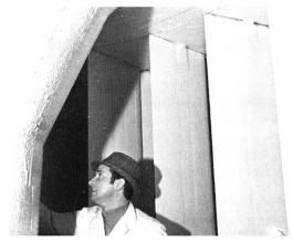
Bild 3. Leitschaufeln und Wasserführungsschild nach der Konservierung mit lösungsmittelfreier Beschichtung.
