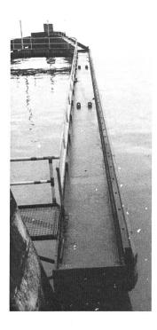
Bild 1. Leitwerk in Stahlbauweise ausgerüstet mit Polyäthylen-Gleitleisten.
