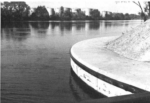
Bild 2. Molenkopf in Betonkonstruktion mit aufgesetzten PE-Gleitleisten als Ramm- und Verschleisschutz. (Werkfotos der Firma Schlegel GmbH, Hamburg)
