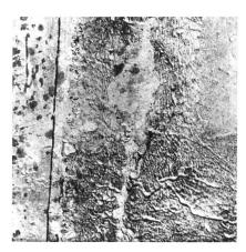
Bild 3. Abblätterungen im Krümmer zum Druckschacht. Angerostete Schiene (für den
