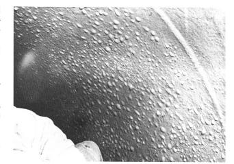
Bild 2. Rostpusteln im Schrägschacht zwischen dem Druckstolleneinlauf und der Wasserschlosskammer.
