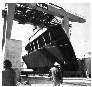
Bild 1. Wehrverschluss eines modernen Donaukraftwerkes. Segment mit Aufsatzklappe, lichte Weite 24 m, Höhe 13,50 m. Der vollständig zusammengebaute Verschlussteil wird eingebaut.
