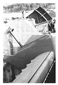
Bild 6. Stauwehr Reichenau I mit drei Segmentklappenschützen, 1962.
