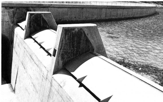
Bild 11. Hochwasserentlastung des Stausees Isola mit drei Stauklappen. Beachtenswert ist die Gestaltung der die Klappen umgebenden Pfeiler. 1959.
