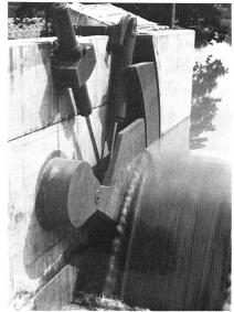
Bild 19. «Eiswehr» Brunau-Zürich. Eine von Doppelsgementklappenschützen, stand beim Überströmen. 1968/69.
