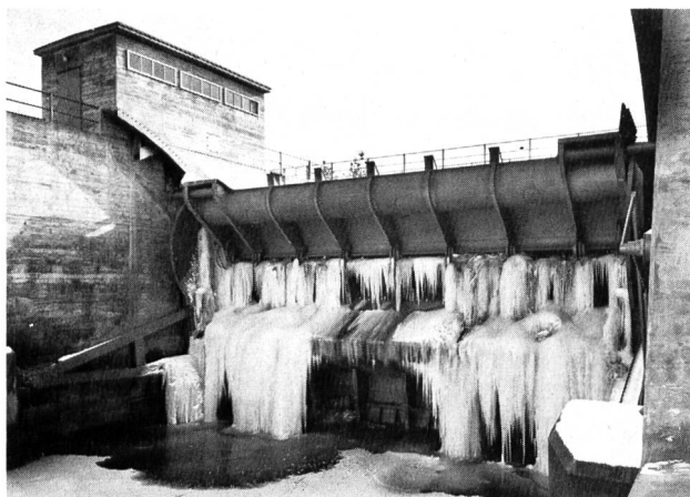
Bild 12. Stauwehr Wildegg-Brugg. Eisbehang an einer der drei Segmentklappenschützen zufolge Undichtigkeit, 1949.
