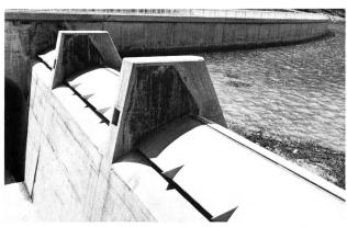
Bild 11. Hochwasserentlastung des Stausees Isola mit drei Stauklappen. Beachtenswert ist die Gestaltung der die Klappen umgebenden Pfeiler. 1959.
