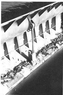
Bild 7. Stauwehr Säckingen. Einer der fünf Segmentklappen-Schützenkörper mit angesammeltem Geschwemmsel. 1966.
