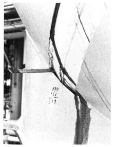
Bild 3, links. Nicht durchgehende Schweissnähte. Aus den Fugen läuft Rostwasser.
