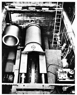
Blick in einen Press-Schacht. In der Mitte unten das Widerlager mit den hydraulischen Pressen, oben das vorgetriebene Betonrohr. Rechts unten die hydraulische Pumpe.
