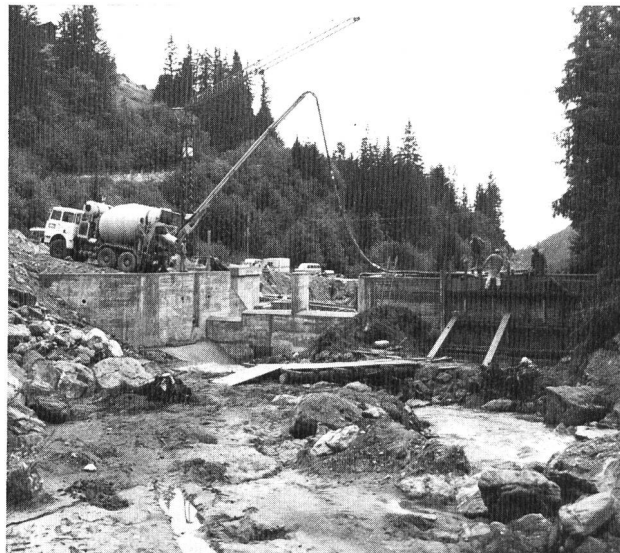
Figure 3. La prise d'eau. Vue amont. Travaux de bétonnage.
