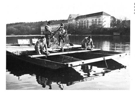
Bild 6. Bootsfloss mit Personal und Einrichtung bei der Aufnahme eines Temperaturquerschnitts im Aareknie. Im Hintergrund die hydraulische Zentrale Beznau.
