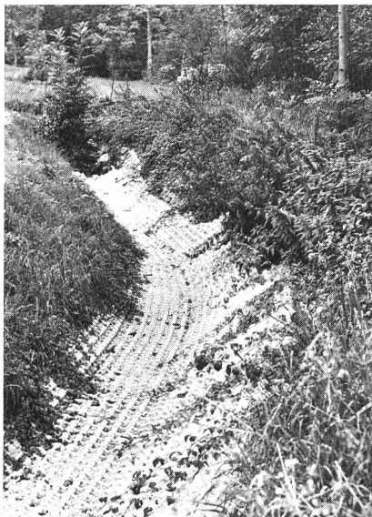
Bild 3. Die UK-Bachverbauung passt sich dem Gelände an.
