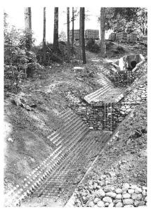
Bild 4. Abstürze verschiedenster Art können Bild 5. UK-Wasserbausystem: die unsichtbare in das UK-System eingepasst werden. Ver- Armierung des Bodens. bindung mit «Gabions».
