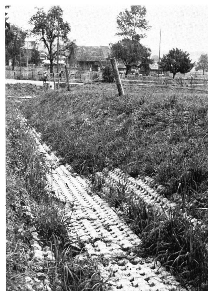
Bild 1, links. Einsatz von UK-Steinen bei einer Kanal- oder Bachverbauung. Oben Schnitt mit Rastermass. Unten seitliche Ansicht. Bezeichnungen: Y10.1 UK-Normalstein, Y10.2 UK-Schrägstein 60.
