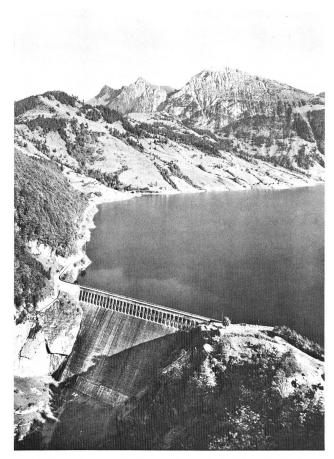
Bild 1. Gewichtsmauer Schräh der Kraftwerke Wägital AG. Die Mauer wurde 1922 bis 1924 gebaut. Im Jahre 1973 wurden die Überwachungseinrichtungen modernisiert und gleichzeitig die Fernübertragung eines Lotmesswertes mit Registrierung im nahegelegenen Dienstgebäude und in der Zentrale Siebnen eingerichtet.
