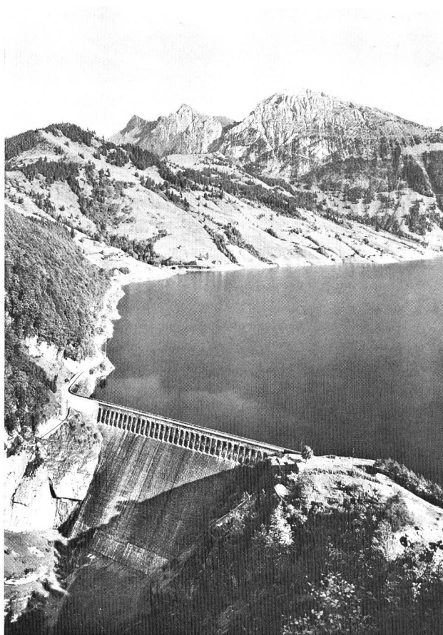
Bild 1. Gewichtsmauer Schräb der Kraftwerke Wägital AG. Die Mauer wurde 1922 bis 1924 gebaut. Im Jahre 1973 wurden die Überwachungseinrichtungen modernisiert und gleichzeitig die Fernübertragung eines Lotmesswertes mit Registrierung im nahegelegenen Dienstgebäude und in der Zentrale Siebnen eingerichtet.
