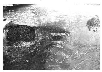
Bild 9. Ueberflutungsversuch im Bauzustand, bei einem Durchfluss durch die Bresche von  $35\ 000\ m^3/s$ .
