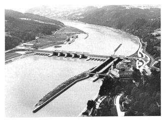
Bild 2. Donau-Staustufe Ybbs-Persenbeug, elektrische Leistung 200 MW, im Vordergrund Schloss Persenbeug. (Foto: Österr. Donau-KW)
