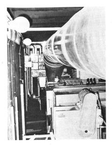
Bild 8, links. Luftentfeuchter, System Munters in einem Werftportal in Schweden.
