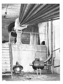
in vier Sektoren eingeteilt, die durch je einen Luftentfeuchter mit einer Leistung von 3000 m³/h mit einem Umwälzgebläse konserviert werden.
