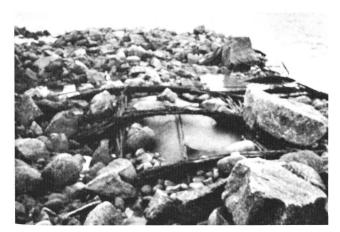
Bild 4. Beschädigtes Deckwerk.
