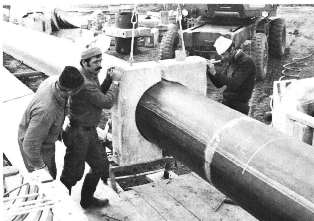
Bild 4. Montage der Beschwerungsklötze.
