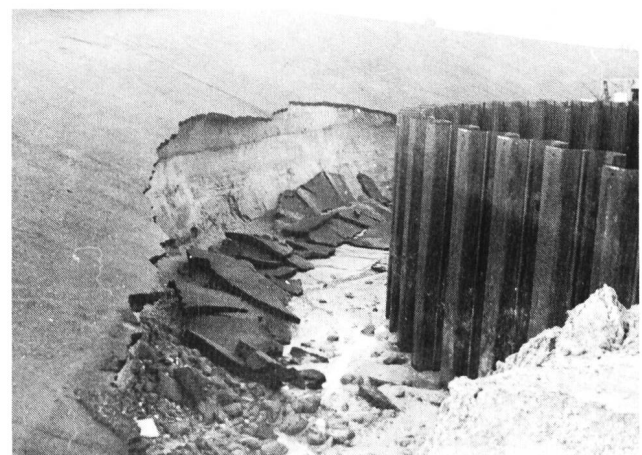
Bild 6. Beschädigte Dachbinnenböschung aus Asphalt nach der Sturmflut 1976.
