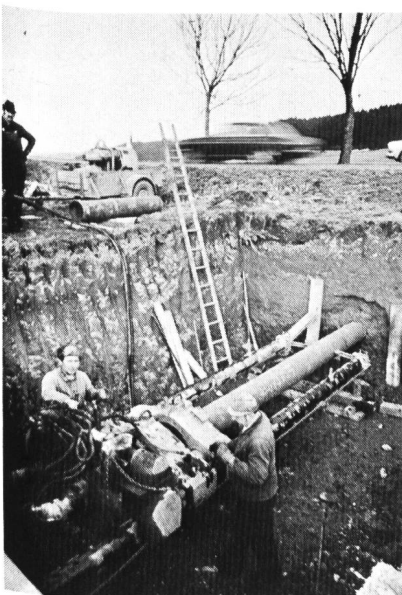
Bild 6. Unterquerung einer Hauptverkehrsstrasse durch Vorpressen eines Mantelrohres und nachträgliches Einziehen des Rohres aus Hostalen 5010.
