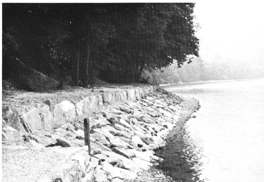
Bild 8. Teststrecke bei Rheinklingen 1976. Bild der fertigen Versuchsböschungen.
