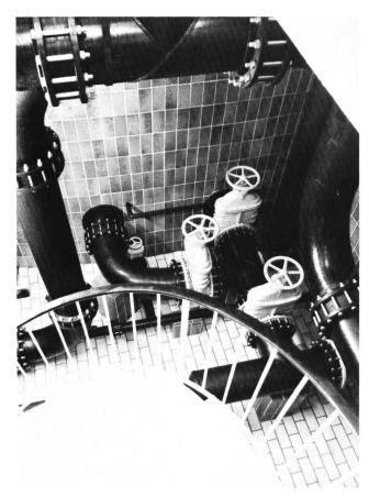
Bild 4. Werkseitig vormontierte Rohrleitungselemente für Spiralleitwandbehälter in der Trinkwasserversorgung.
