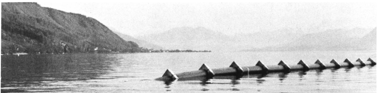
Bild 8. Anheben der Seeleitung über die Schwimmbojen bei der Absenkung.
