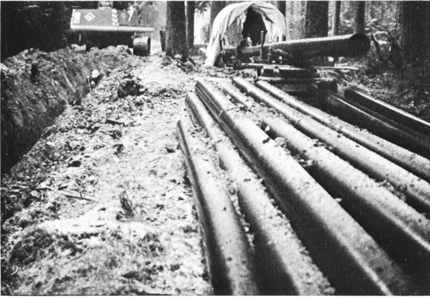
Bild 3. Verschweissen der Rohre aus Hostalen 5010 ausserhalb des Rohrgrabens bei schlechten Witterungsverhältnissen unter einem Zelt.
