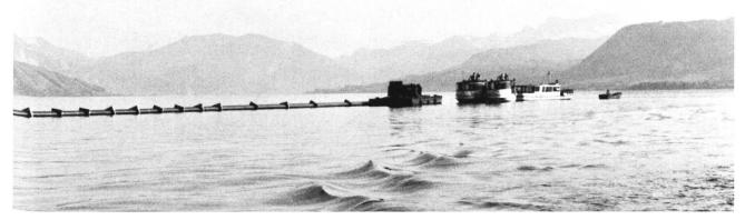
Bild 6. Schiffszug zur Anpassung der Seeleitung am Attersee im Mai 1975. Am Horizont rechts der Schafberg.
