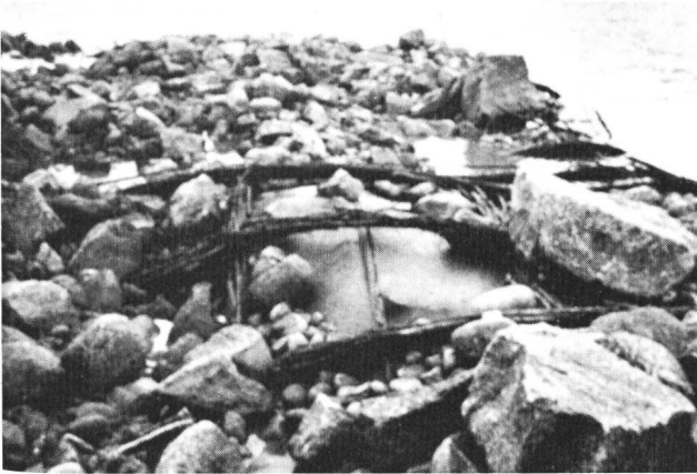
Bild 4. Beschädigtes Deckwerk.
