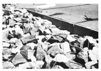
Bild 5. Sohlsicherung.
