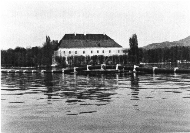
Bild 9. Vorübergehend errichteter Hochpunkt an der Seerohrleitung zur Stabilisierung der eingepressten Luft. Dahinter Schloss Kammer am Attersee.
