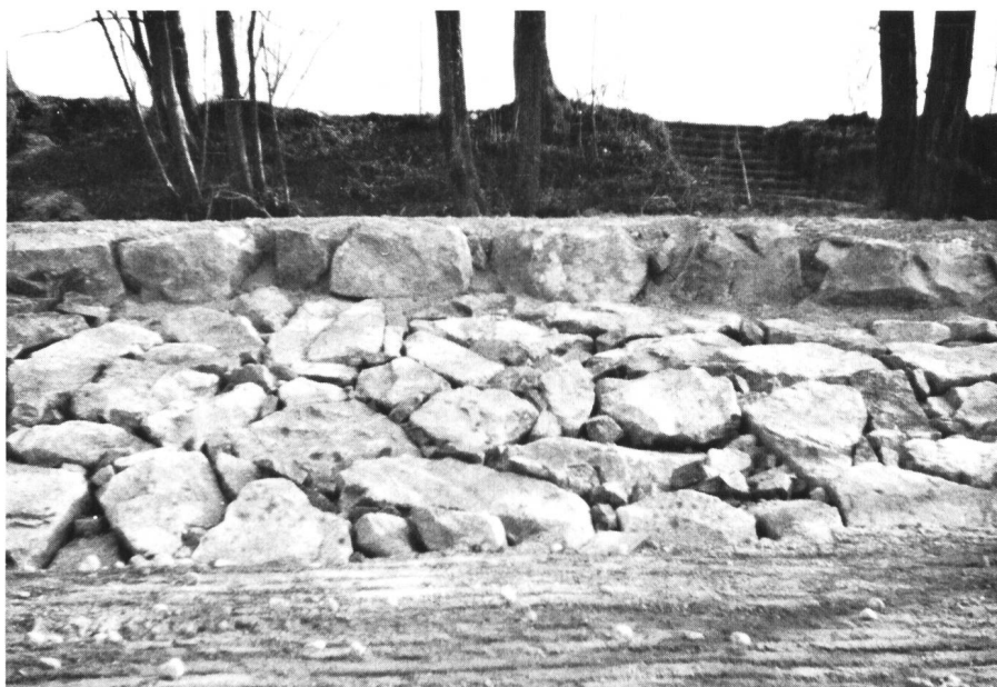
Bild 7. Teststrecke bei Rheinklingen 1976. Die fertige Böschung mit Natursteinen 400 bis 800 kg verkleidet, der obere Abschluss wird von Kopfsteinen, höchstens 1 Tonne schwer, gebildet. Normalprofile Typ A und B.
