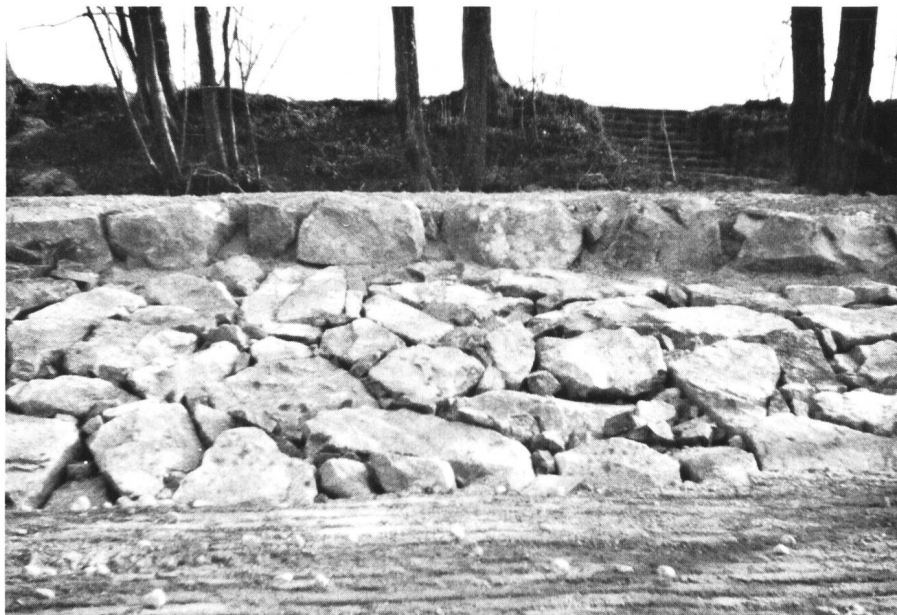
Bild 7. Teststrecke bei Rheinklingen 1976. Die fertige Böschung mit Natursteinen 400 bis 800 kg verkleidet, der obere Abschluss wird von Kopfsteinen, höchstens 1 Tonne schwer, gebildet. Normalprofile Typ A und B.
