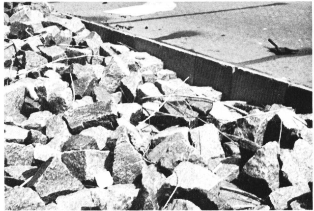
Bild 5. Sohlsicherung.
