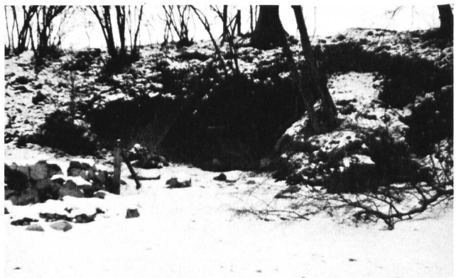
Bild 2. Durch die Rückströmung der auflaufenden Bug- und Heckwellen entsteht eine Absenkungswelle, die als Sog wirkt. Dieser Sog ist massgebend an der Uferzerstörung schuld. Das Bild zeigt eine ausgeschwemmte Rheinuferröschung.
