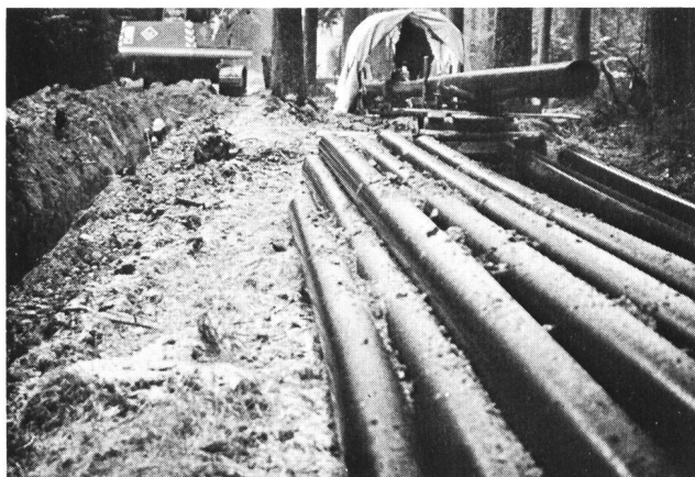
Bild 3. Verschweissen der Rohre aus Hostalen 5010 ausserhalb des Rohrgrabens bei schlechten Witterungsverhältnissen unter einem Zelt.
