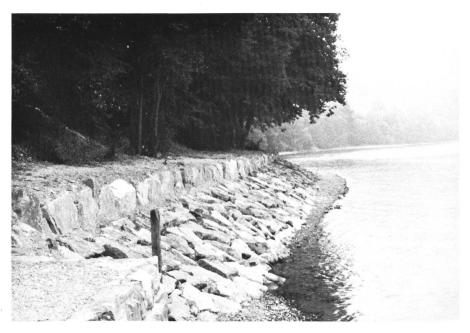
Bild 8. Teststrecke bei Rheinklingen 1976. Bild der fertigen Versuchsböschungen.
