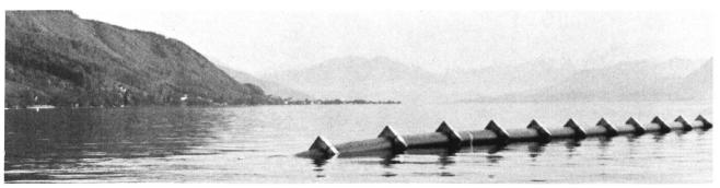
Bild 8. Anheben der Seeleitung über die Schwimmlinie bei der Absenkung
