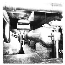
Bild 3. Hinten im Maschinenraum (links im Bild) befinden sich der Wärmepumpenverdampfer (Bild 2, 3) für die Grundwasser-Wärmegewinnung und der zum System der Kunsteisbahn gehörende Kältemediumakku-
