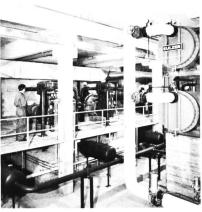
Bild 4. Maschinenraum der Anlage mit den drei Sulzer-Kältekompressoren. Im Vordergrund rechts der aus zwei Apparaten bestehende Kältemediumkondensator (Bild 2, 5) und der drei kleine Apparate umfassende Brauchwarmwasser-Erzeuger (Bild 2, 6).
