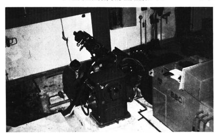
Bild 9. Das 1975/76 erneuerte Kraftwerk Luchsingen im Kanton Glarus. Man erkennt die abgedeckte zweidüsige Peltonturbine und den Verschalten Generator. Die Leistung der Anlage konnte von 1000 kVA auf 2060 kVA gesteigert werden.
