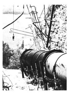
Bild 11. Beim Bau der neuen Druckleitung des Kraftwerkes Robbia konnte das Betonwiderlager der alten Leitung für den Fixpunkt der neuen Leitung mitverwendet werden. Man erkennt die Verankerung der neuen Druckleitung.
