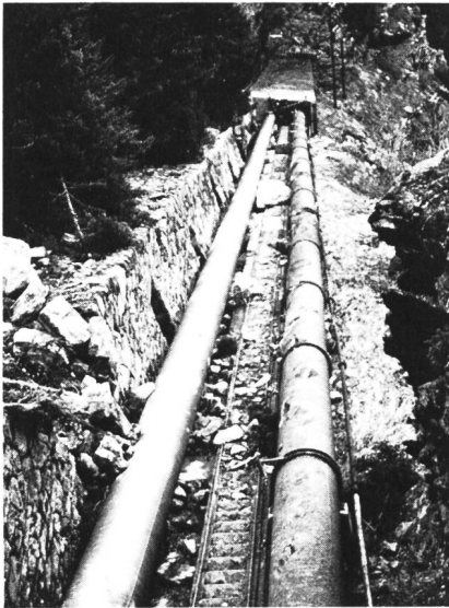
Bild 10. Links die neue (1974), rechts die alte (1910) Druckleitung des Kraftwerkes Robbia der Kraftwerke Brusio AG. Kurz vor der Betriebsaufnahme der neuen Leitung zerstörte am 10. November 1974 ein Steinschlag die alte Druckleitung. Die neue Druckleitung wurde nur leicht beschädigt.
