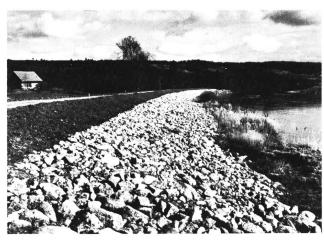
Bild 6. Naturnaher Wasserbau im Gebiet des Geisshofs, Unterlunkhofen: Der Blocksteinwurf des Hochwasserdammes ist (inzwischen eingestaut) kaum mehr sichtbar. (Aufnahme Januar 1975)
