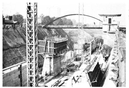
Bild 1. Die Baugrube der zweiten Schleuse Birsfelden Anfang Oktober 1976. Blick stromabwärts; rechts die Mauer des Schleusentroges der ersten Schleuse. Im Hintergrund die Notbrücke für die Zufahrt zum Kraftwerk Birsfelden.
