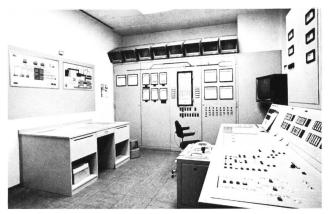
Bild 18. Zentralwarte im Rheinkraftwerk Albbruck-Doggern für die Fernsteuerung und Fernüberwachung des Maschinenhauses, des Wehrs, des Aubeckens und des Pumpwerks Full.
