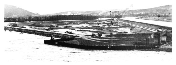
Bild 13. Hochwasser im Rhein von etwa 2200 m³/s am 10. Februar 1977. Im Vordergrund fliesst der Rhein unterhalb des Wehrs an der Baugrube für den Auslaufkanal vorbei (von rechts nach links). Vom rechten Bildrand gegen die Bildmitte verläuft die Fliessrichtung des Oberwasserkanals des Rheinkraftwerks Albbruck-Dogern. Rechts die Baugrube des Ein- und Auslaufbauwerks, in Bildmitte die Aushubarbeiten für das Aubecken.
