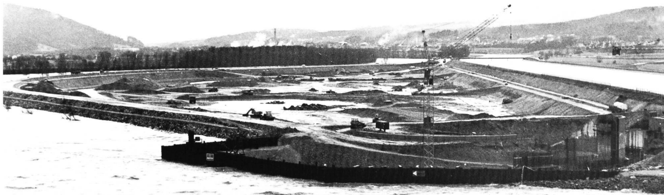
Bild 13. Hochwasser im Rhein von etwa 2200 m 3 /s am 10. Februar 1977. Im Vordergrund fließt der Rhein unterhalb des Wehrs an der Baugrube für den Auslaufkanal vorbei (von rechts nach links). Vom rechten Bildrand gegen die Bildmitte verläuft die Fließrichtung des Oberwasserkanals des Rheinkraftwerks Albruck-Dogern. Rechts die Baugrube des Ein- und Auslaufbauwerks, in Bildmitte die Aushubarbeiten für das Aubecken.
