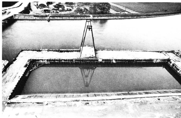
Bild 15. Baustelle des Fangedammes Werkkanal, November 1976. Der Werkkanal verläuft von rechts nach links.
