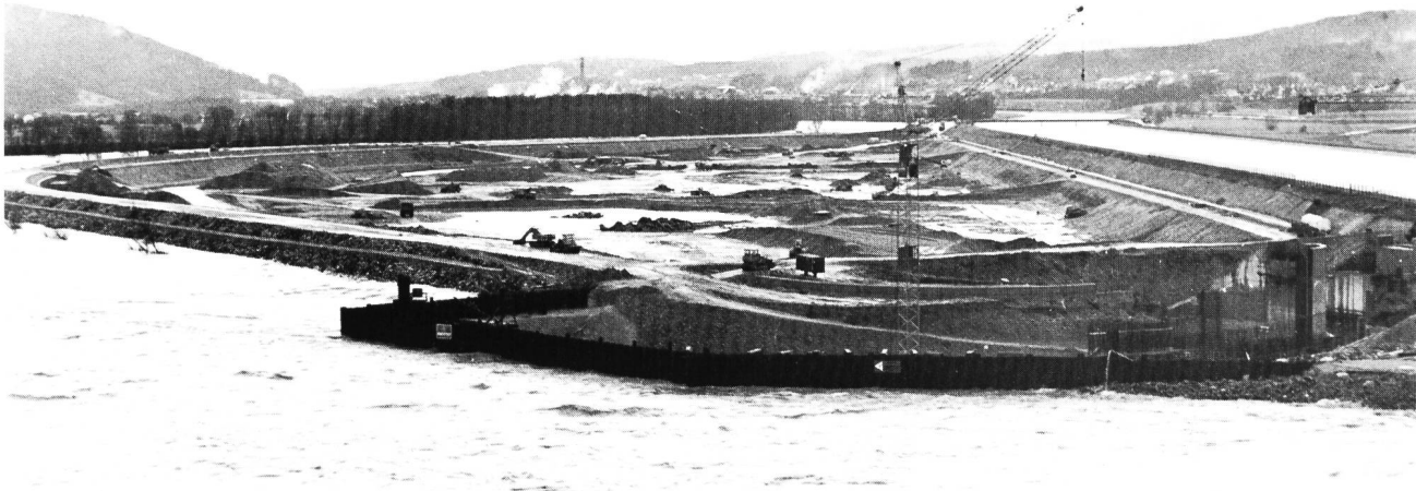
Bild 13. Hochwasser im Rhein von etwa 2200 m 3 /s am 10. Februar 1977. Im Vordergrund fließt der Rhein unterhalb des Wehrs an der Baugrube für den Auslaufkanal vorbei (von rechts nach links). Vom rechten Bildrand gegen die Bildmitte verläuft die Fließrichtung des Oberwasserkanals des Rheinkraftwerks Albruck-Dogern. Rechts die Baugrube des Ein- und Auslaufbauwerks, in Bildmitte die Aushubarbeiten für das Aubecken.
