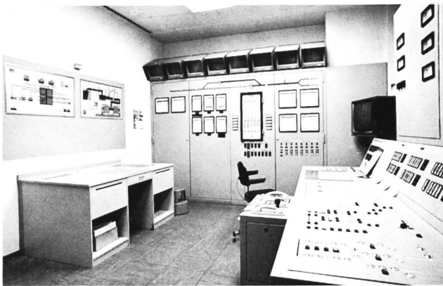
Bild 18. Zentralwarte im Rheinkraftwerk Albruck-Dogern für die Fernsteuerung und Fernüberwachung des Maschinenhauses, des Wehres, des Aubeckens und des Pumpwerks Full. Warte rechts: Maschinensteuer- und Instrumententafel. Bildmitte: Wasserwirtschaft und Fernsehen. Links: Protokollschreiber für die Datenverarbeitungsanlage.
