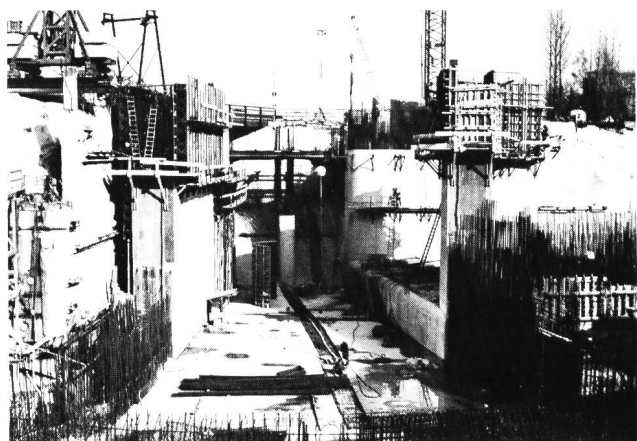
Bild 9. Das Einlaufbauwerk im November 1976.
