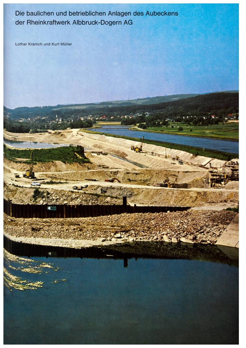
Sonderdruck aus «Wasser, Energie, Luft — Eau, énergie, air» 69 (1977) Heft 6/7. Bild auf der Vorderseite: Aufnahme der Baustelle für das Aubecken im Juli 1976. Im Vordergrund fliesst der Rhein von rechts nach links. Die Spundwand schliesst die Baugrube für den Auslauf aus dem Becken in den Rhein ab. Im Mittelgrund sind die Aushubarbeiten für das Becken im Gange. Beim Damm zwischen dem Aubecken und dem Oberwasserkanal, der von rechts nach links fliesst, arbeitet ein Kran an der Schlitzwand.
