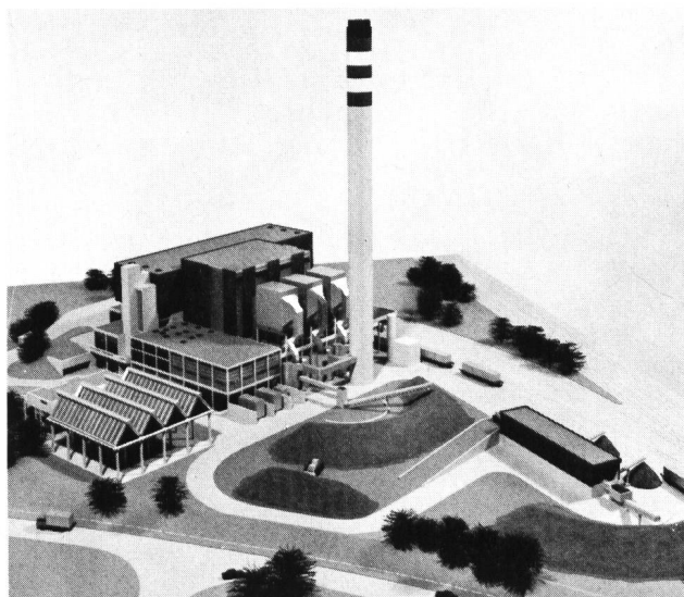
Bild 1. Planungsmodell einer Müllverbrennungsanlage mit angeschlossener Aufbereitung für Verwertung der Müllschlacke im Strassenbau. (Widmer + Ernst AG, 5430 Wetztingen)
