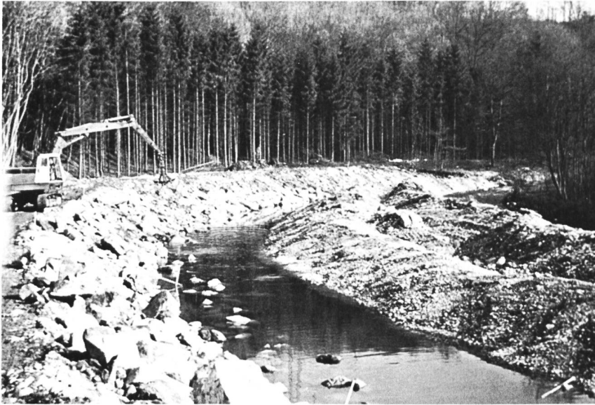
Bild 1, links. Die Glattkorrektion bei Windlisböden, oberhalb Glattfelden. Die Böschung wird mit Bruchsteinen gesichert. Ein Mitteldamm ermöglicht eine Wasserhaltung und das Arbeiten im ruhenden Wasser.
