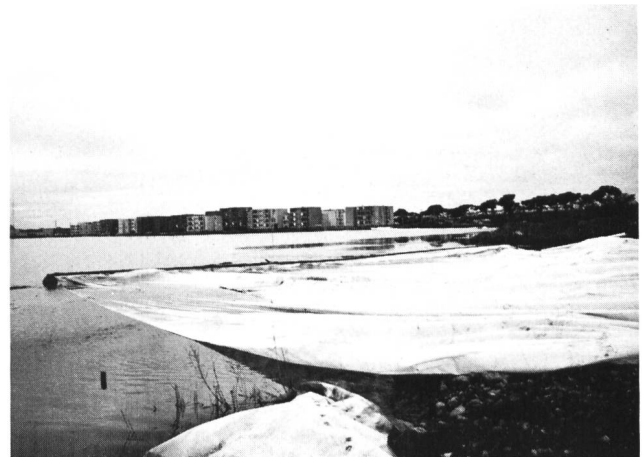
Bild 1. Einschwimmen von Terram-Vliesen 280 als Trennschicht zwischen dem schlechten, schlammigen Untergrund und der Aufschüttung eines Uferdammes. Die Bahnen wurden zu einem grossflächigen Vlies zusammengenäht. Im Hintergrund Fos sur Mer.
