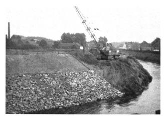
Bild 4. Fertiggestelltes Teilstück und Beginn der Planierung des nächsten ausgekolkten Abschnitts.
