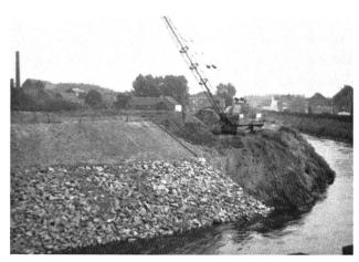
Bild 4. Fertiggestelltes Teilstück und Beginn der Planierung des nächsten ausgekolkten Abschnitts.
