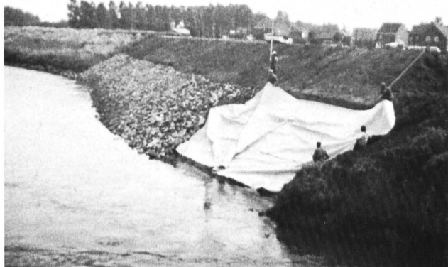
Bild 2. Ausbreiten einer Vliesmatte aus Trevira-spunbond auf dem geplanten Dammschnitt.
