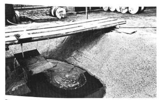
Bild 3. Füllen einer Grube mit Hilfe eines Prallbleches.
