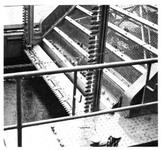
Bild 2. Mähboot «Müro III» des Kantons Zürich. Zwei vertikal angeordnete und ein horizontaler Mähbalken dienen dazu, eine Schneise von 3 m Breite und bis 2,25 m Tiefe auszumähen. Ein Elevator bringt das abgeschnittene Flussgras an Deck des Bootes.
