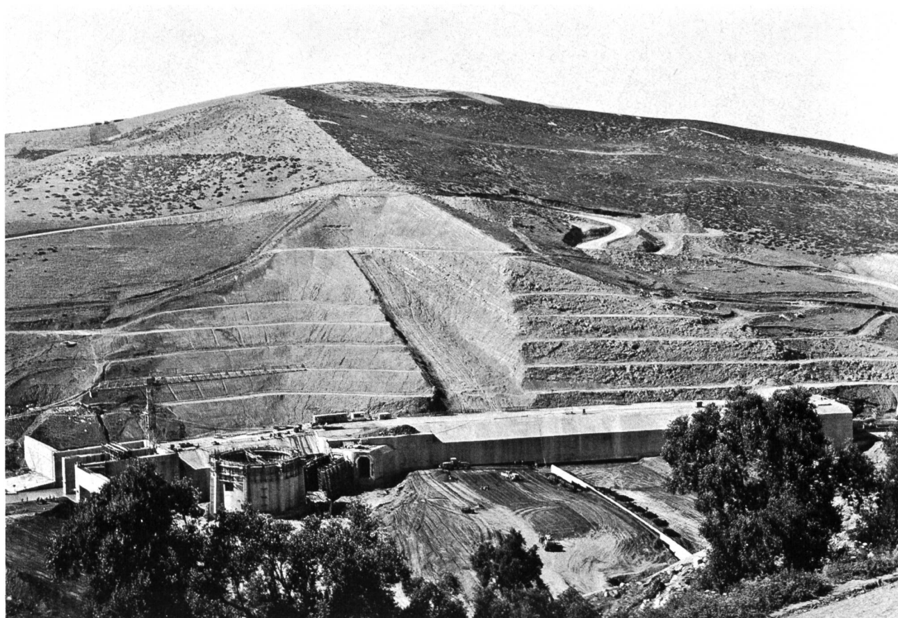
Bild 2. Mehrzweckanlage Oued El Makhazine am Flusse Loukkos in Marokko. Das Bild zeigt den Aushub für den Staudamm und das Betonbauwerk für die Umleitung während des Baus.
