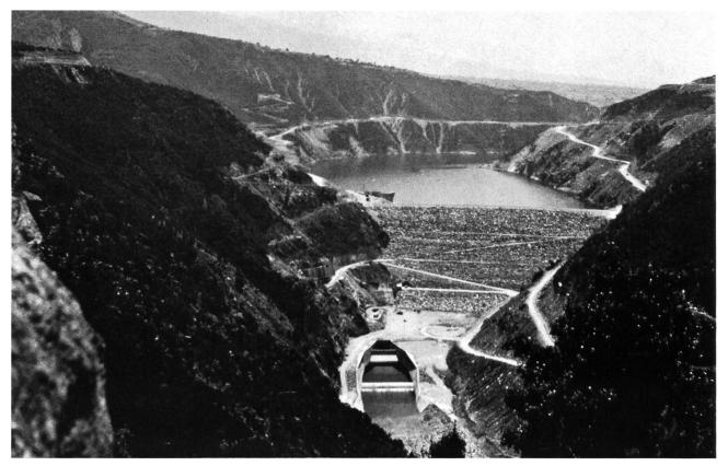
Bild 1. Wasserkraftwerk Polyphyton am Aliachmon in Griechenland. Der Steinschüttdamm von 105 m Höhe staut einen See von rd. 2000 Mio m³ Inhalt. Die Anlage ist mit 3 Turbinen zu je 120 MW Leistung ausgerüstet.
