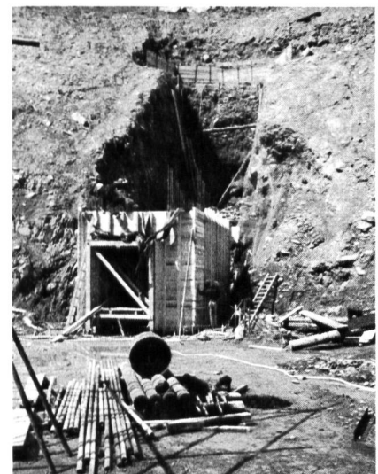
Bild 3. Ausführung der Drainagebohrungen im Injektionsstollen.
