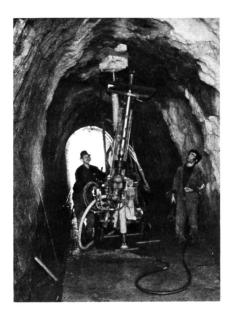
Bild 3. Ausführung der Drainagebohrungen im Injektionsstollen.
