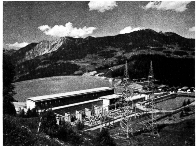
Bild 3. Lünserseewerk mit Latschaubecken I und II; rechts im Bild der Pumpwasserkanal.
