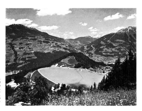
Bild 8. Latschaubecken I und II, im Hintergrund Schruns. Die Becken I und II sind durch einen Zwischendamm getrennt, dessen Kronenhöhe 5,25 m unter dem Stauziel liegt, so dass der darunterliegende Teil der Bekken getrennt bewirtschaftet werden kann. Ein im Zwischendamm mit Absperrschütze versehener Stollen stellt die Verbindung beider Becken her.
