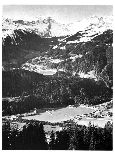
Zum Beschrieb der Kraftwerkgruppe Obere III-Lünersee der Vorarlberger IIIwerke AG: Gefällstufe Latschau-Rodund; in Bildmitte Lünerseewerk mit Staubecken Latschau, im Tal Pumpspeicherbecken mit Rodundwerk I und Rodundwerk II.
