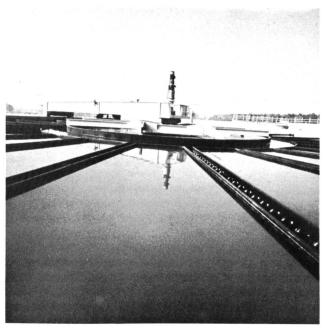
Bild 9. Flockungsreaktor der neuen Anlage. Décanteur floculateur de la nouvelle station de traitement.
