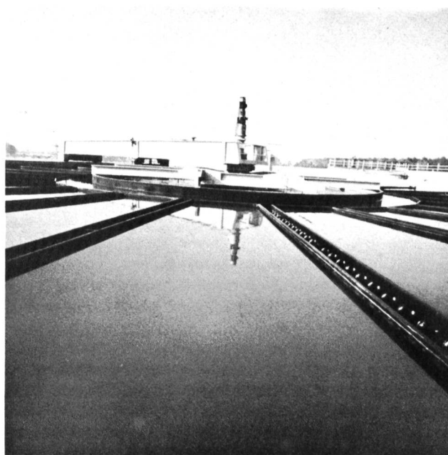
Bild 9. Flockungsreaktor der neuen Anlage. Décauteur flocculateur de la nouvelle station de traitement.
