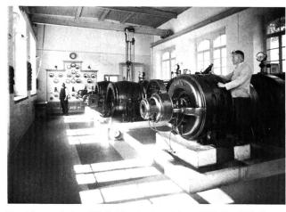
Maschinensaal des EW Heiden in den Jahren 1907 bis 1923. Damalige installierte Leistung 360 kVA, Bruttogefälle 198 m. Die mittlere Gruppe wurde 1923 durch eine neue Gruppe von 350 kVA ersetzt. Zurzeit wird die ganze Anlage revidiert, wobei die Einheit mit 350 kVA als Reserve bestehen bleibt und die beiden äussern Maschinen durch eine solche von 480 kVA ersetzt werden. Neue Verwendung hauptsächlich zur Erzeugung von Spitzenenergie.
