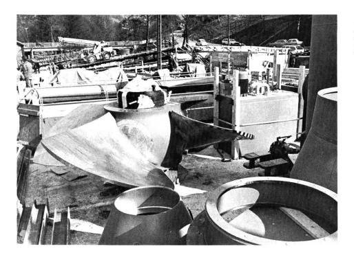
Bild 2. Das Kaplan-Turbinenrad, Durchmesser 3650 mm, steht auf der Decke des neuen unterirdischen Maschinenhauses bereit, um rund 10 m tiefer eingebaut zu werden.
